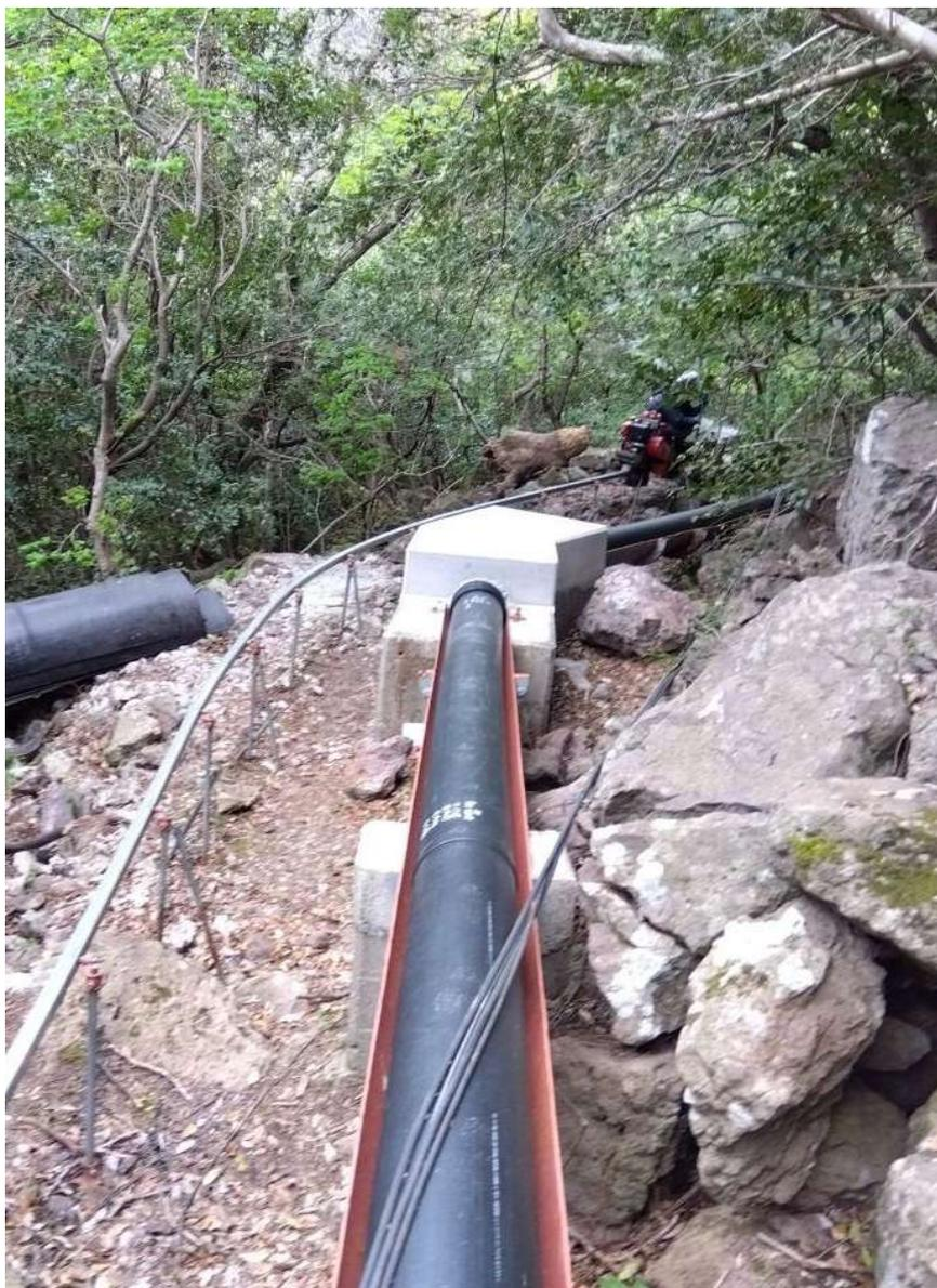
島根県隠岐の島 油井発電所配管入替他工事 流入管部 (199Kw、発電事業者(株)鴻池組)
