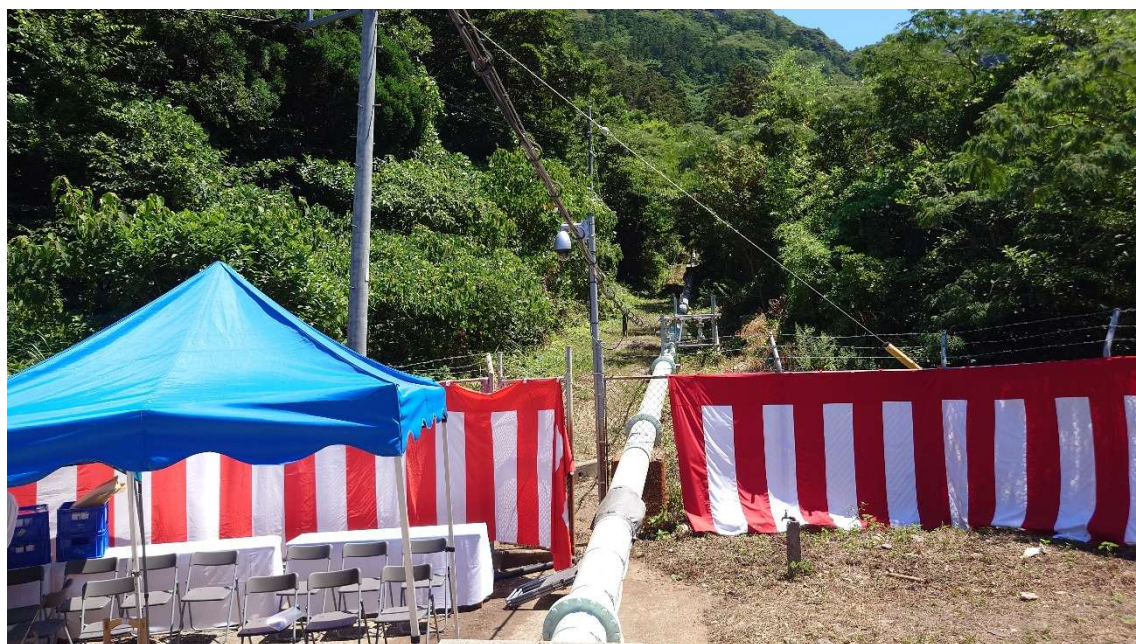
島根県隠岐の島 油井発電所配管入替他工事 竣工（発電事業者㈱鴻池組）
