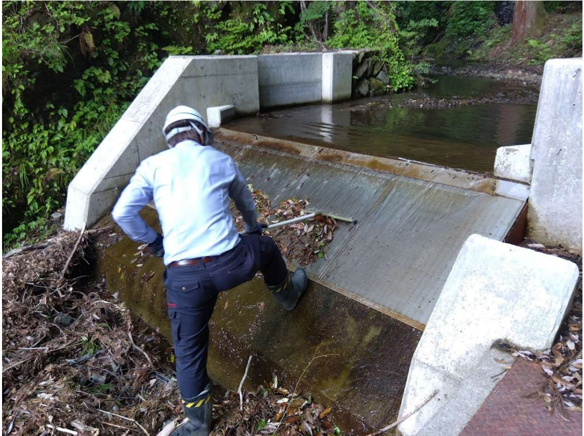
取水の妨げになる落ち葉などの除去作業を行う
