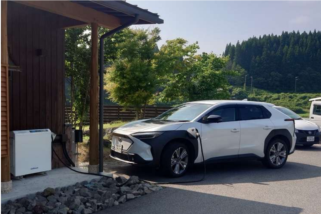
会社に設置した充電設備で充電するEV(Electric Vehicle)
